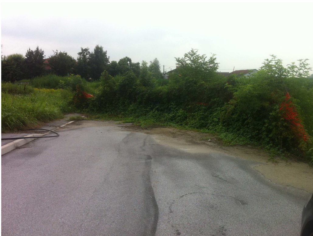
L'area d'interesse vista da via Einaudi (strada interrotta- in corrispondenza del nuovo ponte veicolare)
